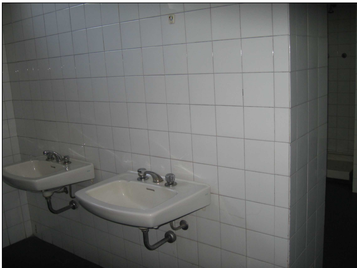
Foto n° 25 - Immagine lavandini blocco bagni
