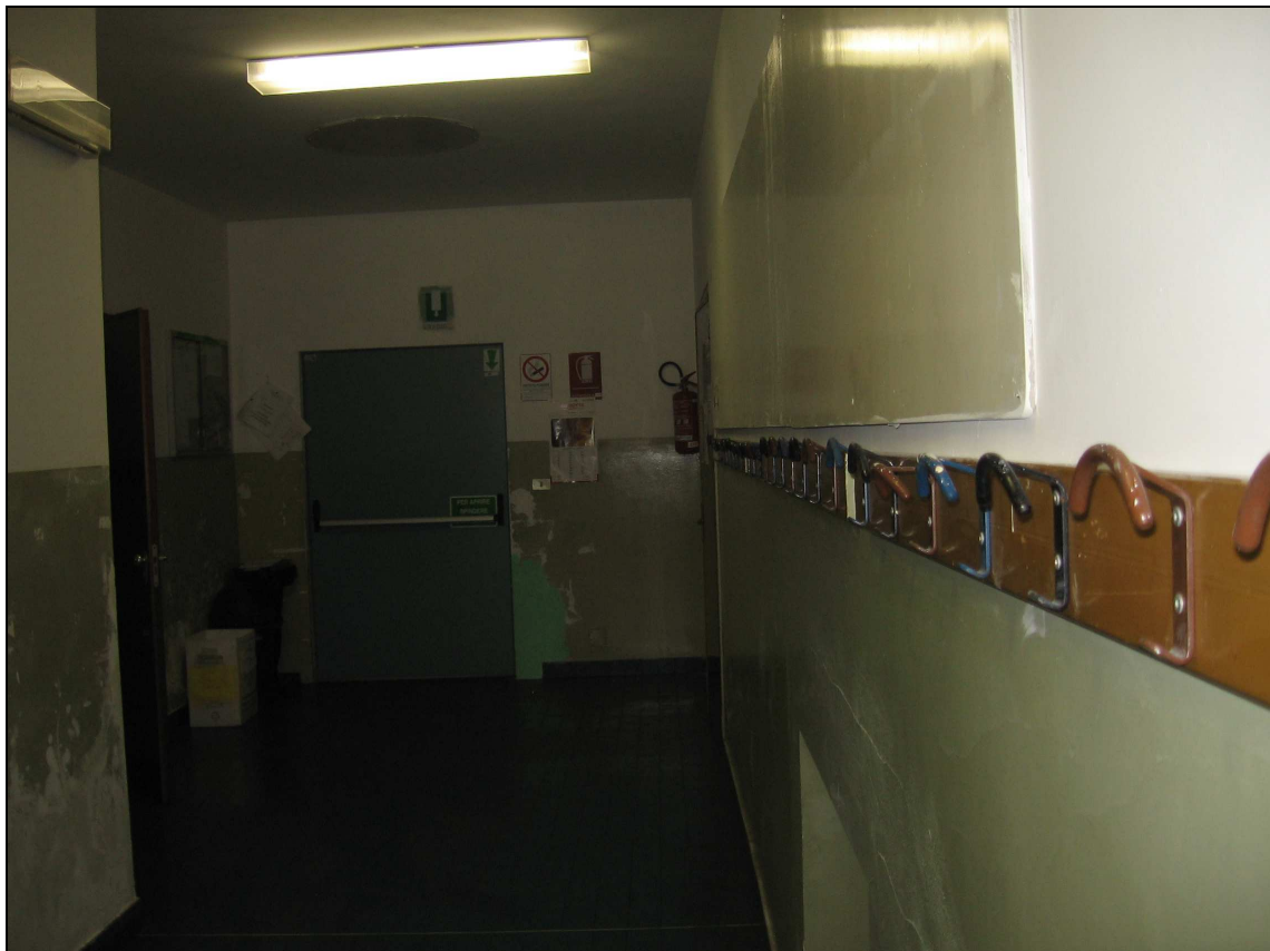
Foto n° 16 - Immagine del corridoio blocco bagni sull'entrata
