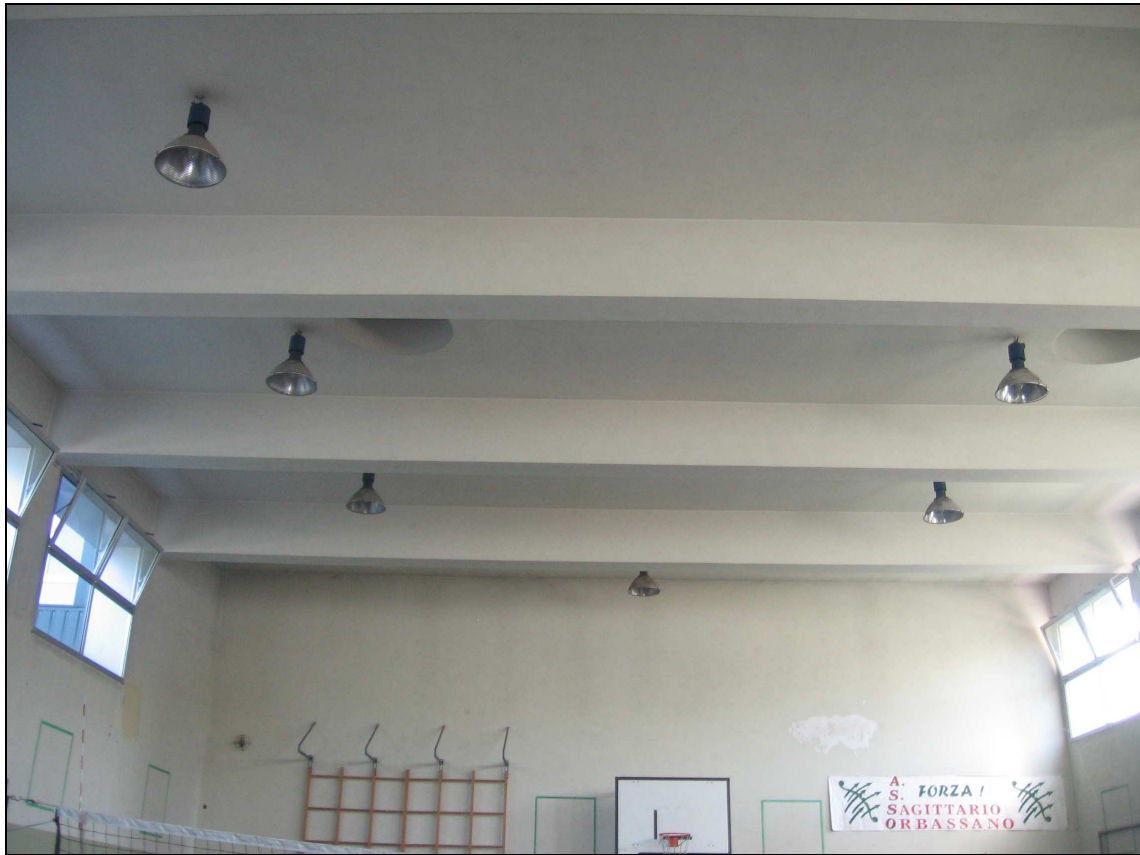
Foto n° 15 - Immagine del soffitto e pareti palestra
