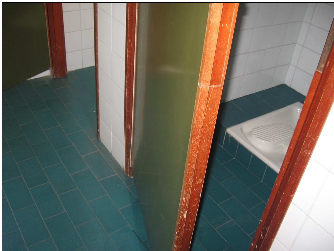
Foto n° 23 - Immagine porte interne blocco bagni
